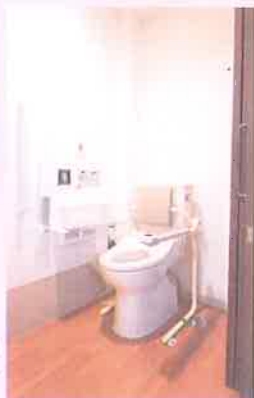
「ユーカリ小金原」の各居室にあるトイレ。寄りかかれるように背もたれが付いているうえ、前側にも、排便時に寄りかかってお腹に力を入れられるように跳ね上げ式のバーが付いている
