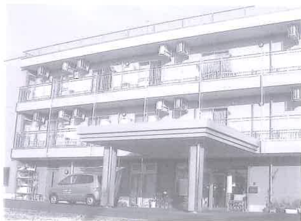
▲介護付有料老人ホームの外観
